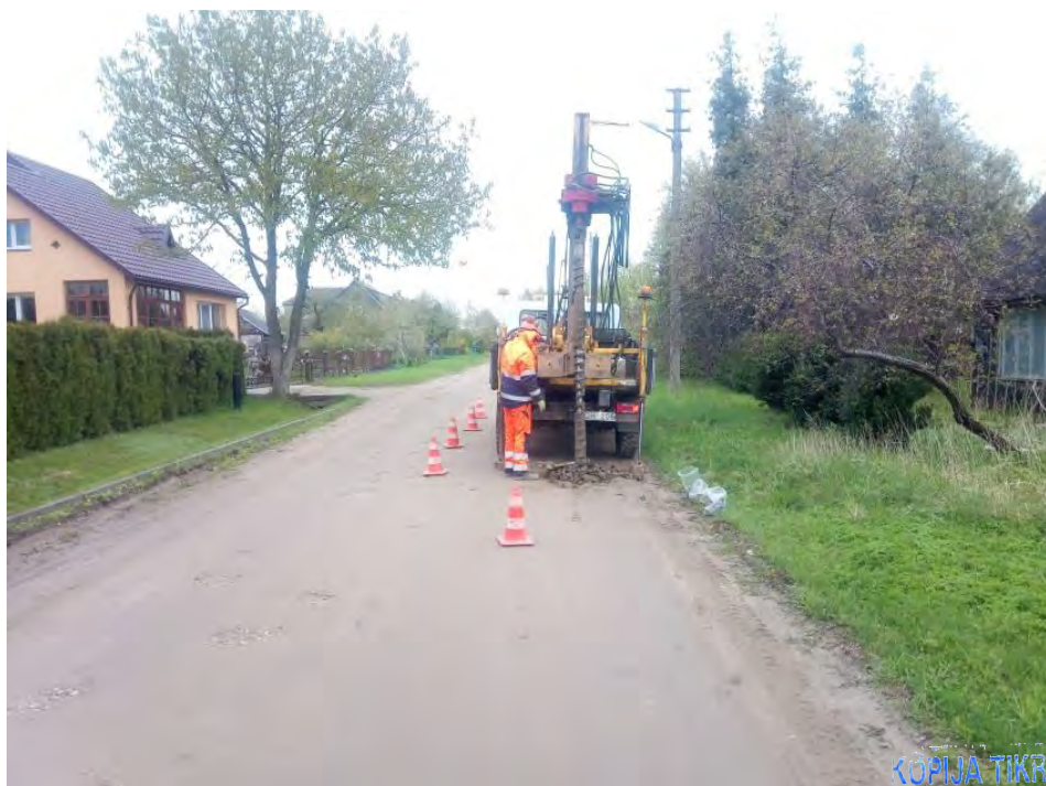
1 pav. Lauko darbai
